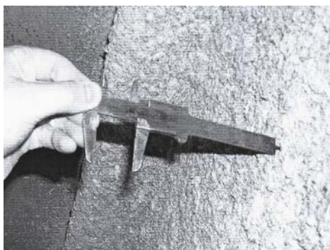
Рис.4. Измерение толщины покрытия штангенциркулем.
